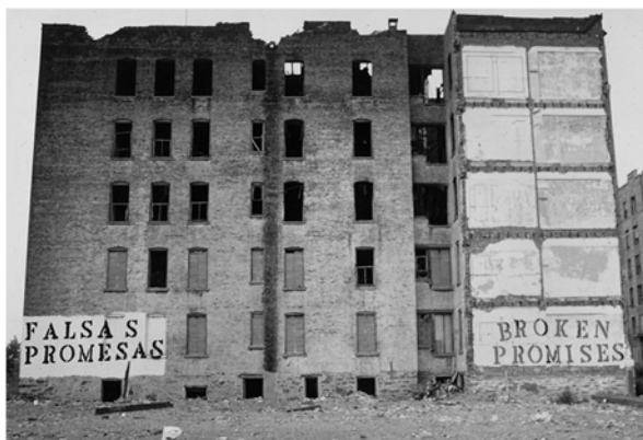
John Fekner, Broken Promises - New York, USA 1980
